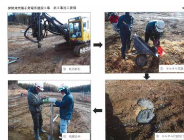
施工状況①～④
