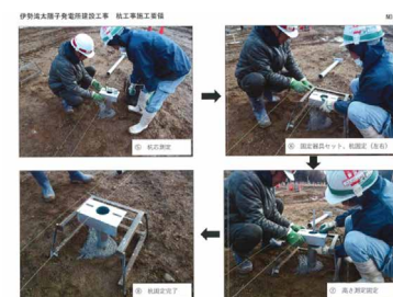
施工状況⑤～⑧
